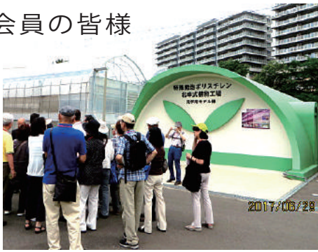
▲高気密・省エネドーム（人工光型） 極めて高い断熱性気密性を備えた特殊発 泡ポリスチレンドーム植物工場
